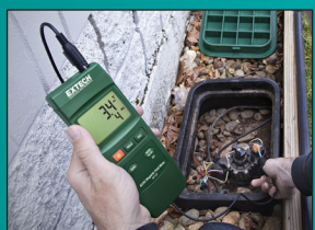
AC magnetisch veld uitgang van sprinklerrelais systeem meten
